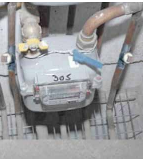
TE DE PRUEBA EN INSTALACIONES CON MEDIDOR
